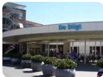
De Dilgt Dilgtweg 3 9751 ND Haren
